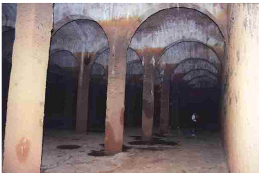
Interior del dipòsit, amb les columnes i les voltes
