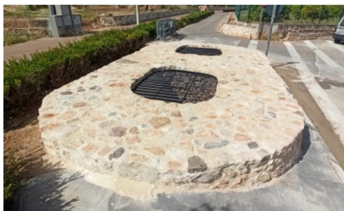
El nou aspecte del pou després de les obres
